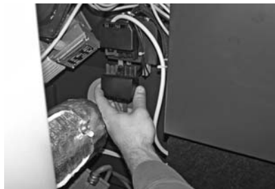
Abb. 153 Gebläsestecker abziehen
