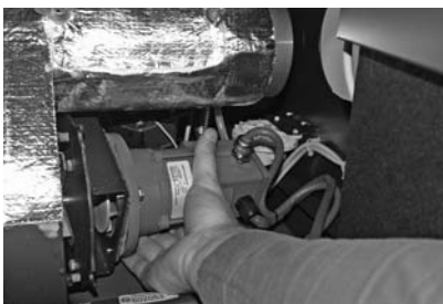
Abb. 154 Flügelmutter entfernen, Gebläseeinheit herausnehmen
