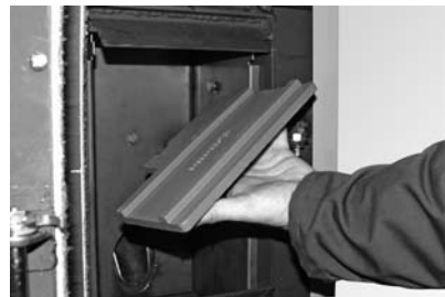
Abb. 126 Umlenkplatte herausnehmen, reinigen
