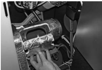
Abb. 152 Flügelmutter und Reinigungsabdeckung entfernen - Abgasrohr reinigen
