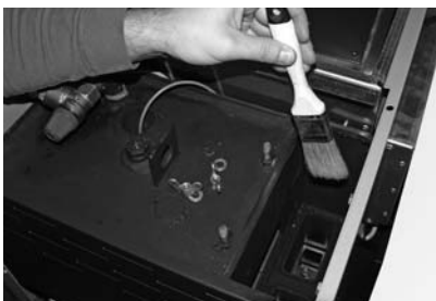
Abb. 145 Heizflächen oben und Gestänge reinigen
