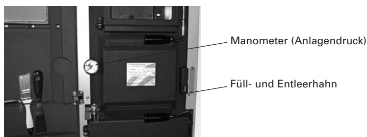
Abb. 8 Anlage füllen
