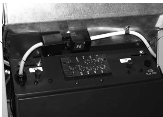
Abb.160 FireWIN Schaltfeld, rechte Seitenwand hinten abgenommen
